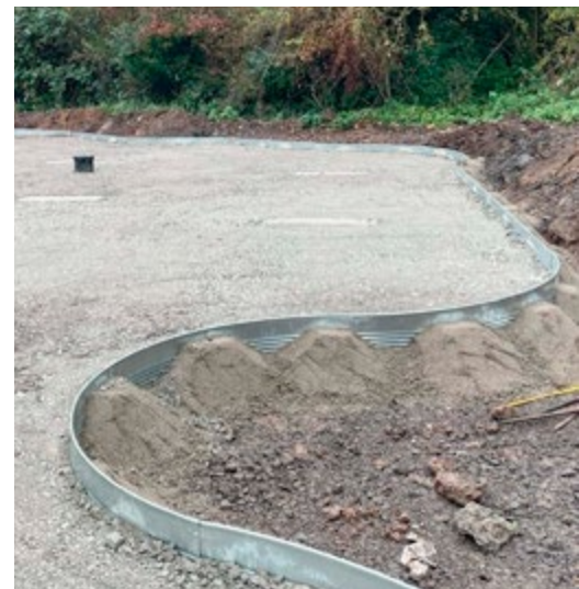
Einbau der vorgebogenen Profile
