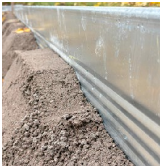
Einbau in Beton ohne Erdanker
